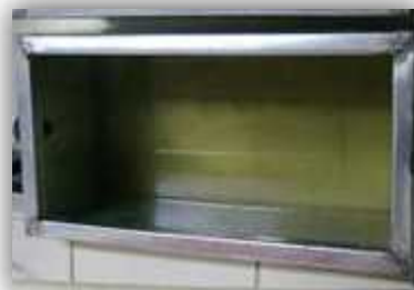
Figura N° 19: Tanque de almacenamiento de agua residual urbana tratada.
