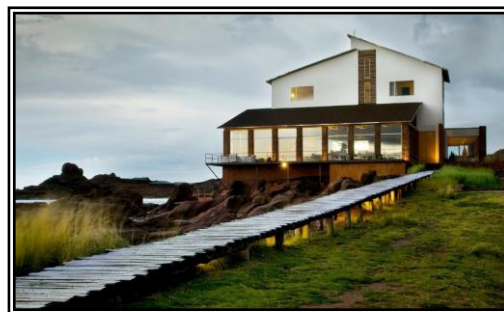
Figura 31. Vista del muelle en madera Hotel "Titolaka" – Acora
