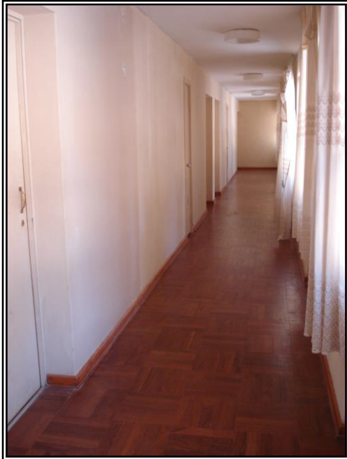
Figura 7. Vista Interior del pasadizo en el “Ex Albergue turístico de Juli”
