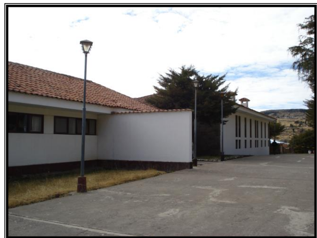
Figura 4. Vista de la Pista de Maniobras del “Ex Albergue turístico de Juli”
