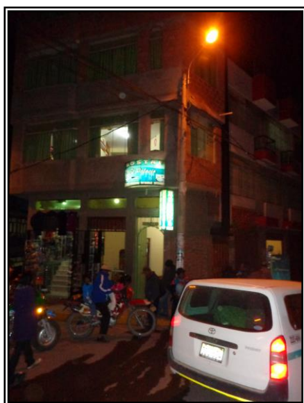
Figura 61. Aspectos de la fachada principal del Hostal “El Palacio” en horas de la noche.
