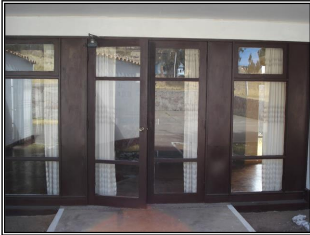
Figura 5. Vista Exterior del acceso secundario al salón de Juntas “Ex Albergue turístico de Juli”
