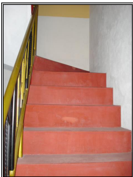
Figura 66. Aspecto de la circulación vertical en el Hostal "J & M"
