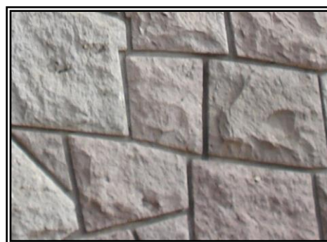
Figura 86. Vista de la textura enchape de piedra tallada utilizado en el “Ex albergue de Turistas Juli. Fuente. Elaboración Propia
