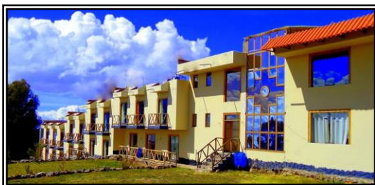
Figura 25. Fachada balconada lateral del Hotel "Pumakala" – Chucuito
