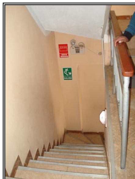
Figura 54. Aspecto de la circulación vertical en el Hostal “Los Ángeles” Fuente. Propia
