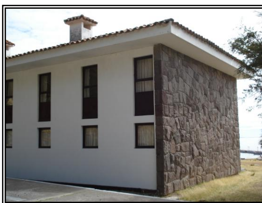
Figura 83. Vista del módulo sureste con enchape de piedra tallada “Ex Albergue de turistas Juli”
