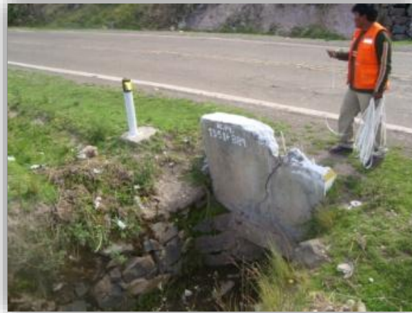
Figura 7. Levantamiento de la Infraestructura vial: Alcantarillas
