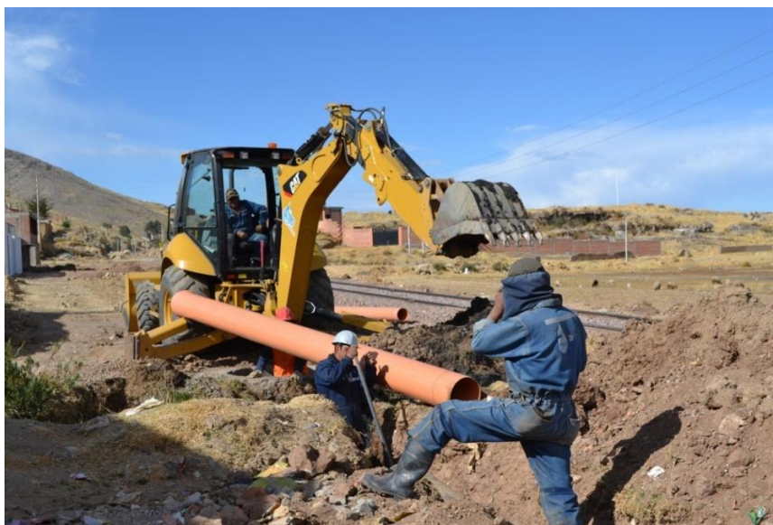
FIGURA 57: Sistema de Alcantarillado.
