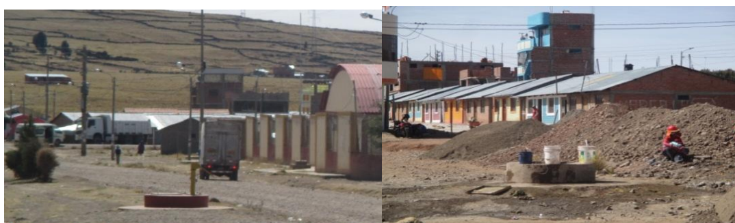
FIGURA 181: Pozos de agua – Sector Totorani.
