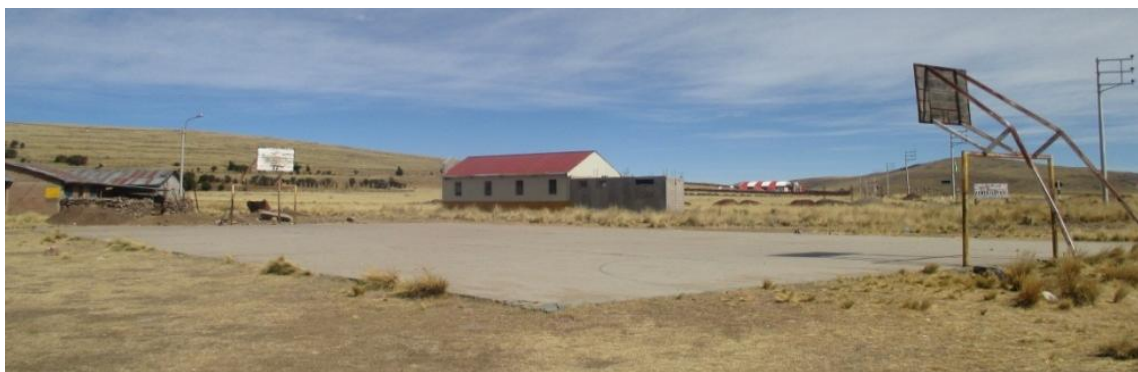
FIGURA 176: Losa Deportiva - Urb. Ciudad de la Humanidad.
