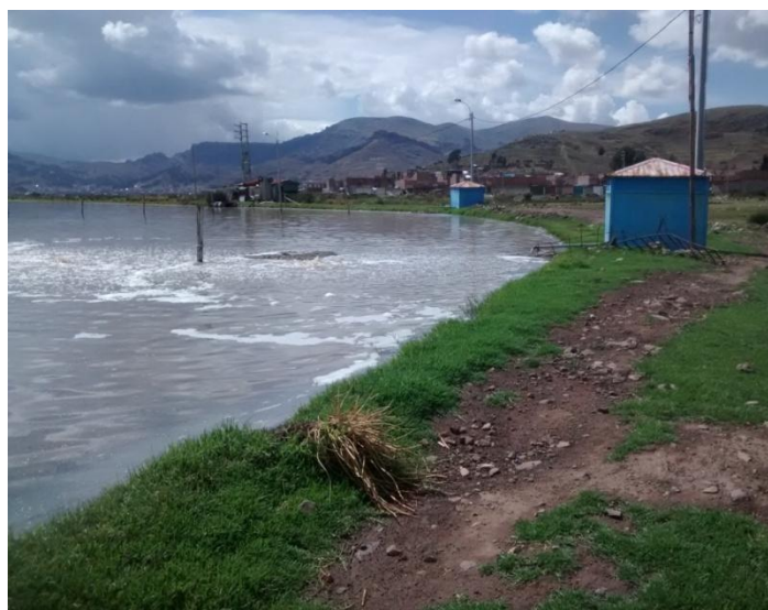
FIGURA 55: Laguna de Oxidación Espinar.
