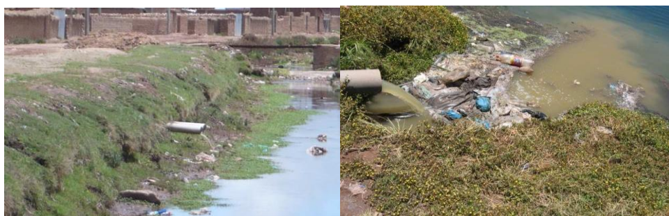
FIGURA 56: Prolongación Av. Costanera, Instalación Clandestina de Desagüe.
