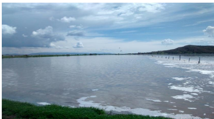
FIGURA 62: Laguna de Oxidación.
