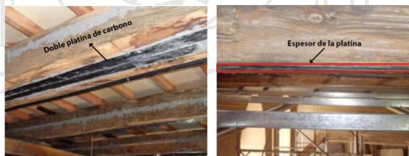
Figura 2.43. Reforzamiento estructural mediante fibras de carbono (Enríquez, 2014).
