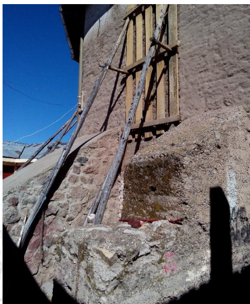
Figura 3.29. Vista fotográfica de los contrafuertes.
