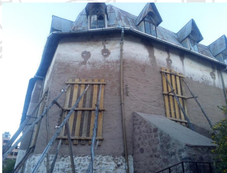
Figura 3.10. Vista intervención de emergencia de la Capilla Cristo Pobre.
