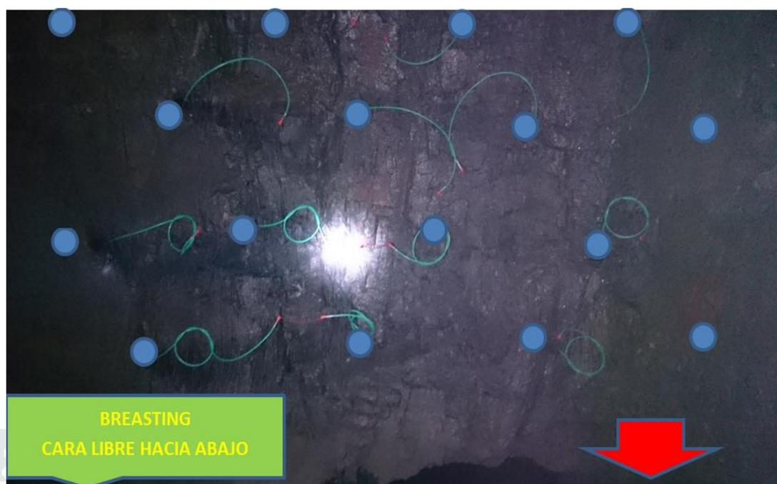
Figura 19: Secuencia de salida en breasting
