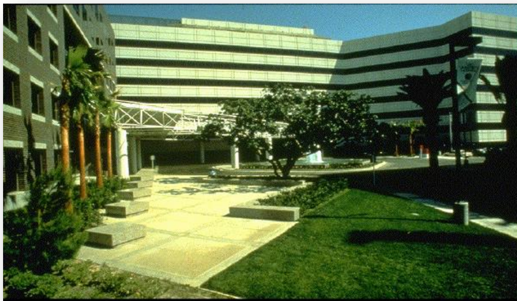
EEUU , USC University Hospital, 68 LRB en el perímetro y 81 HRD Interior (Fuente: Diplomado UPC).
