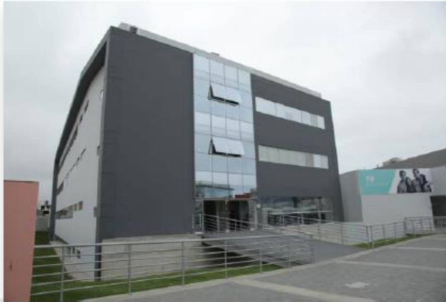
PERU , Universidad Peruana de Ciencias aplicadas, pabellón de ciencias de la salud 18 aisladores 6 deslizadores (Fuente: Diplomado FiC UNI).
