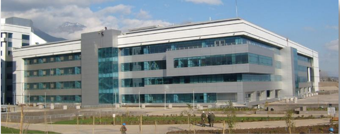
CHILE , Hospital Militar de la Reina, 164 aisladores elastoméricos (50 con núcleo de plomo) a nivel del cielo del subterráneo (Fuente: Diapositiva Empresa VULCO).
