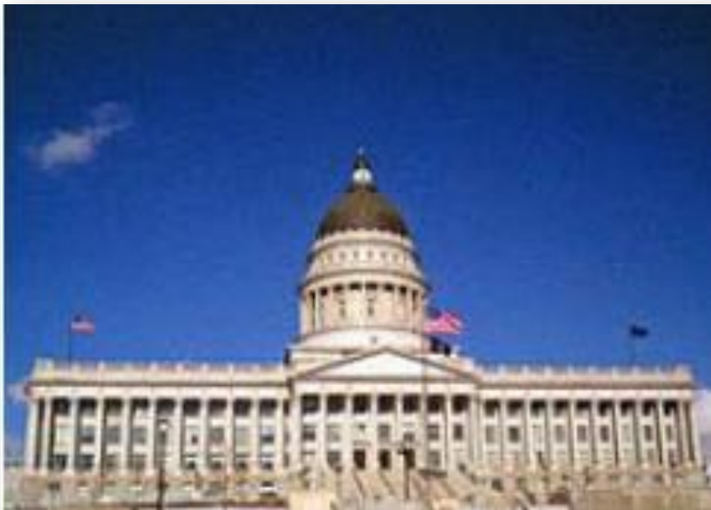
EEUU , Utah State Capitol, el sistema de aislamiento de la base se compone de 265 aisladores (Fuente: Tesis teoría de aislamiento sísmico para edificaciones).
