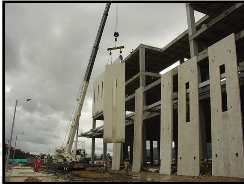
FIGURA 73: Colocación Con Grúa De Bloques TILT - UP.
