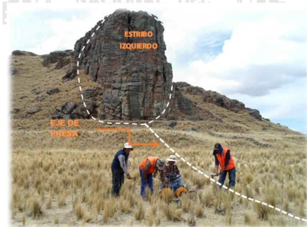
Figura N° 22: Estribo izquierdo del eje de represas.
