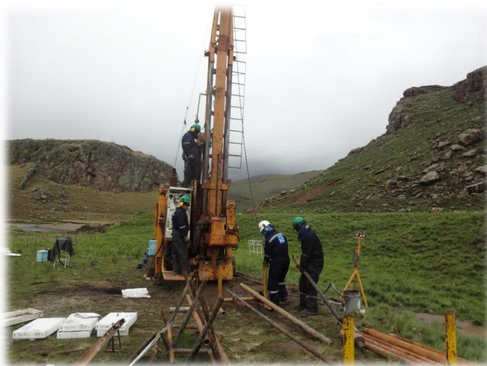
Figura N° 12: Ejecución de perforación diamantina en el eje del represamiento.
