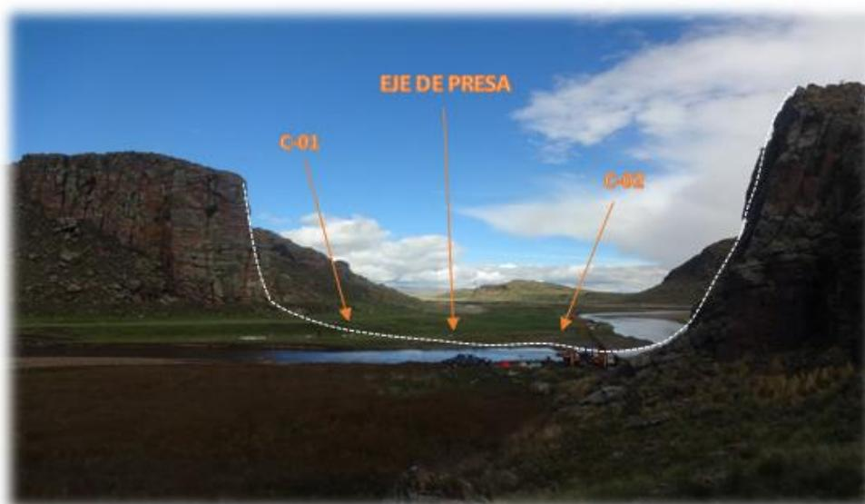
Figura N° 20: Puntos de excavación de calicatas en el eje del represamiento.
