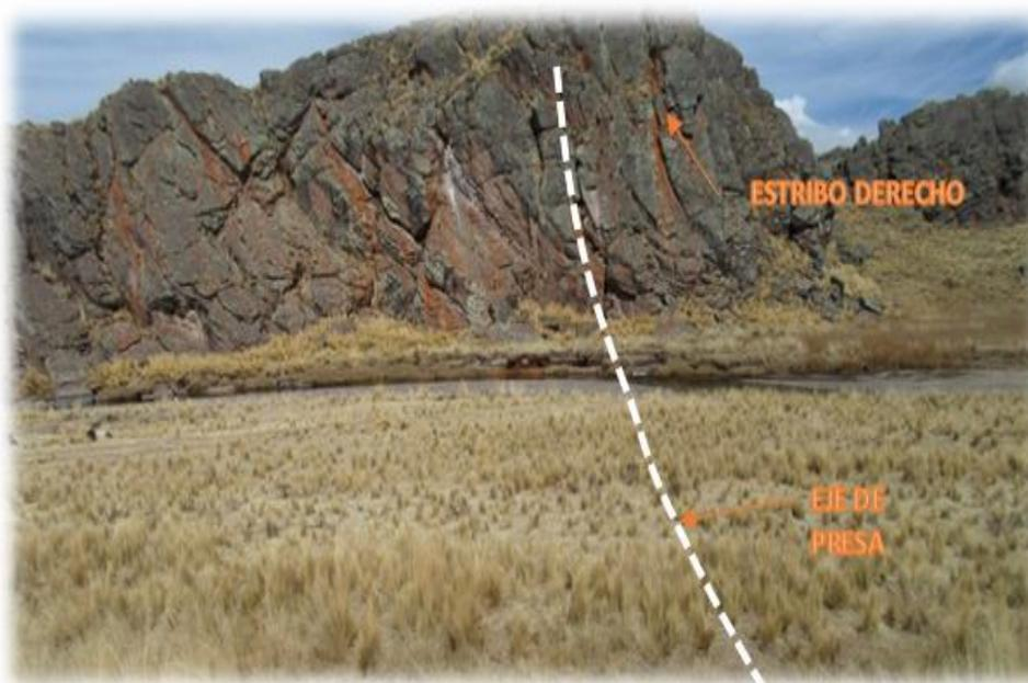
Figura N° 24: Estribo derecho del eje del represamiento.
