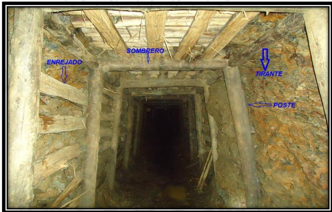
Figura N° 11: Sostenimiento de labores mineras Subterráneas
