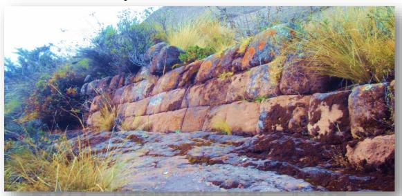
El andén de salida mide 120 metros de largo, 3 metros de altura y 2 metros de ancho promedio. El andén esta levantado con bloques de piedras talladas y unidas sin argamasa, incluso aún se puede observar cuatro hiladas de piedras construidas.
