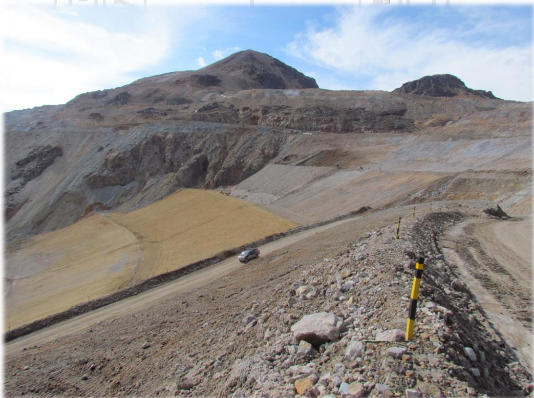
Foto 6. Descarga en el Lift 3 Botadero Jesica – Mina Aruntani
