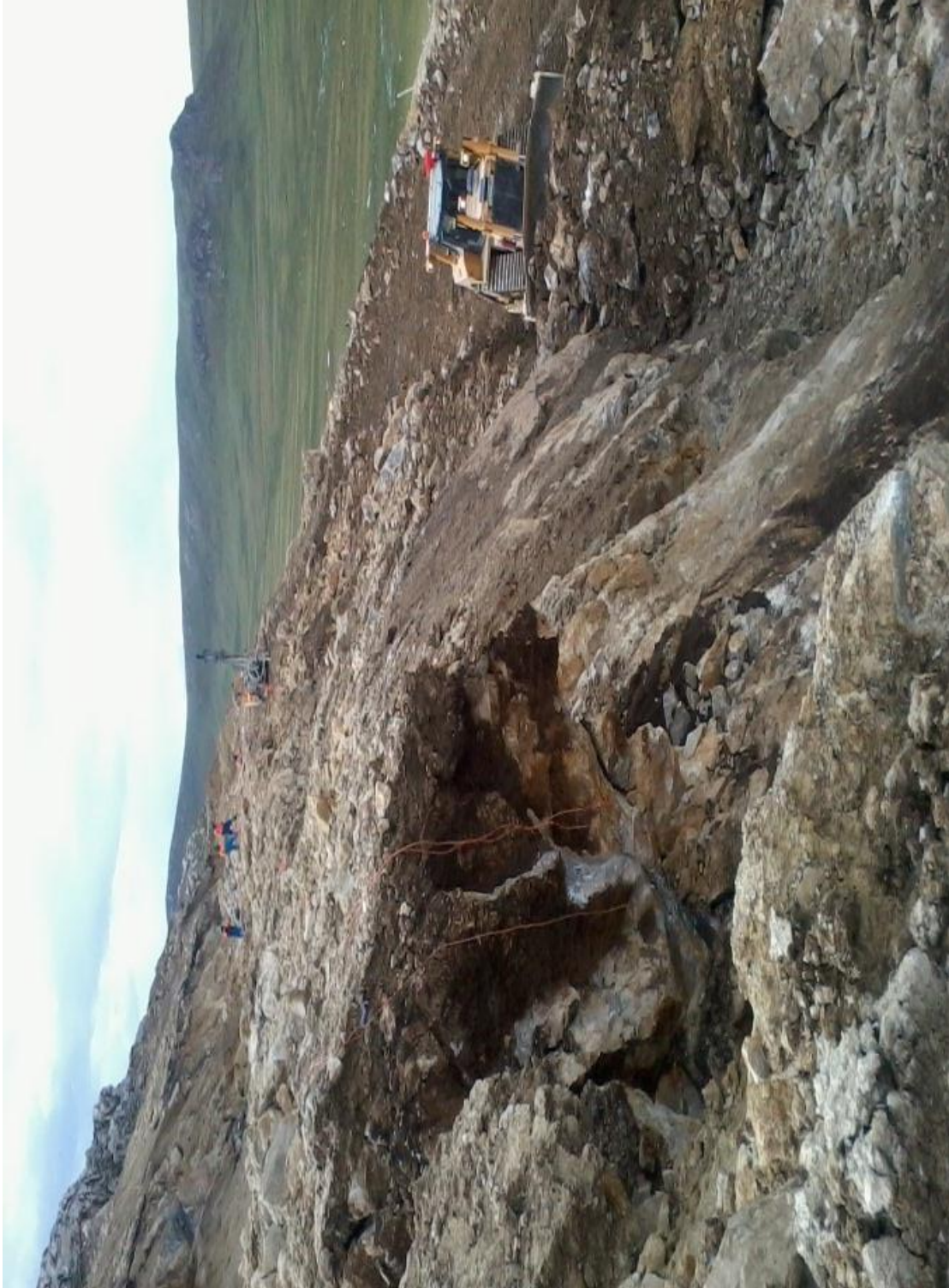
Anexo D.2: Resultados en el cuarto disparo, se obtiene fragmentación gruesa
