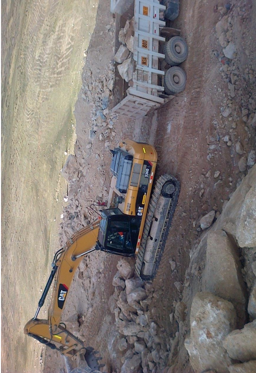
Anexo D.5: Carguío del material seleccionado
