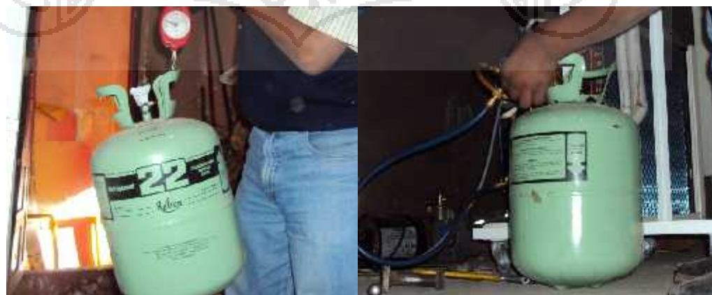
FIGURA 19. REFRIGERANTE 22 UTILIZADO PARA EL SISTEMA.
