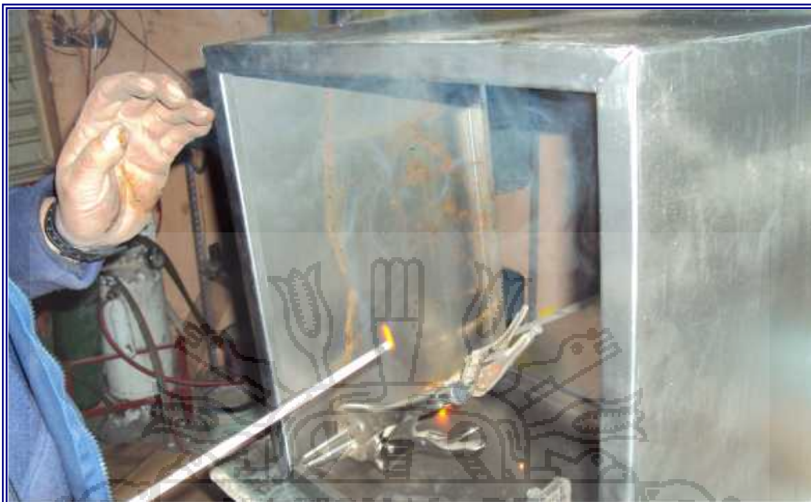
FOTO 3. CONSTRUCCIÓN DE LA COBERTURA EXTERNA DEL TANQUE CONTENEDOR (AGOSTO, 2010).
