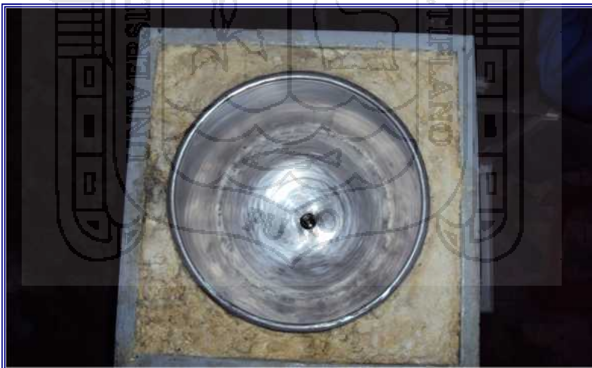
FOTO 4. ACONDICIONAMIENTO DE AISLANTE TÉRMICO (POLIURETANO) EN LAS PAREDES LATERALES DEL TANQUE CONTENEDOR (AGOSTO, 2010).
