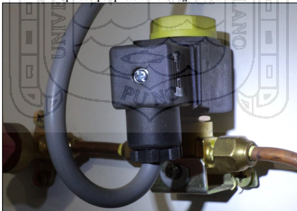
Figura N° 06: Válvula de solenoide de dos vías, normalmente cerrada, operada por piloto con diafragma flotante.
