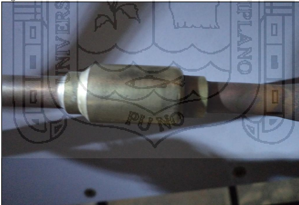
Figura N° 12: Válvulas de retención check
