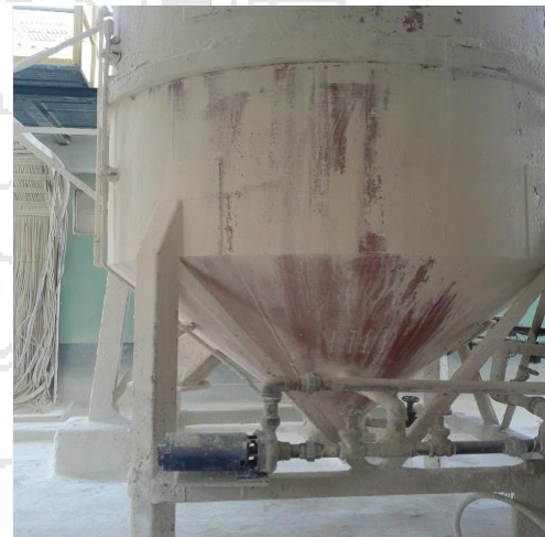
Fig. 22. Bombas de agua 100 lpm.
