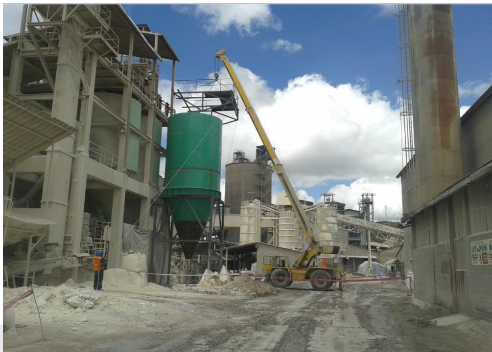
Fig. 27. Montaje de silo alternativo de cal hidratada.
