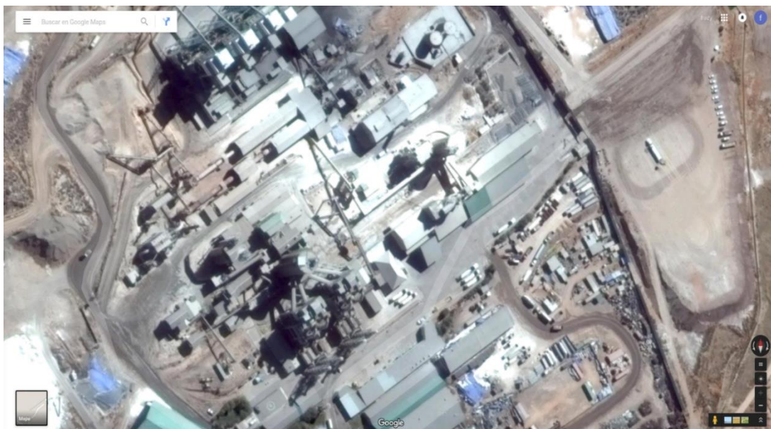
Fig. 14. Planta molienda e hidratación de CAL & CEMENTO SUR SA.
