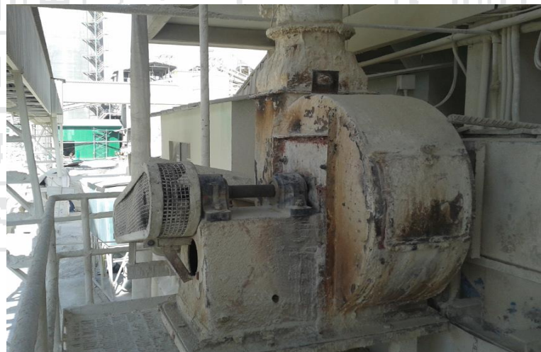
Fig. 17. Ventilador extractor de vapor de agua.
