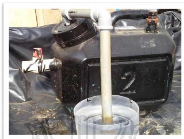
Fig. 3 Módulo de biodigestión anaerobio
