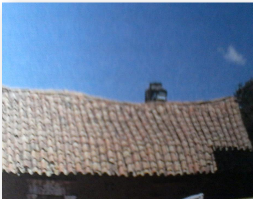
Foto N° 7: Techo de Casona
