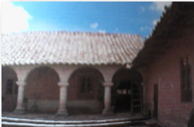
Foto N° 16: Las Arcadas y el Corredor Cobijo de la Casona de la Familia Chuquiuanca
