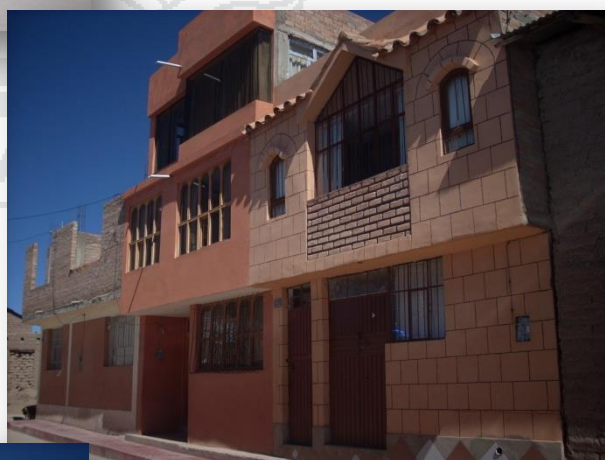
Foto N° 9: Vivienda Típica en la Parte Perimetral del Centro Histórico
