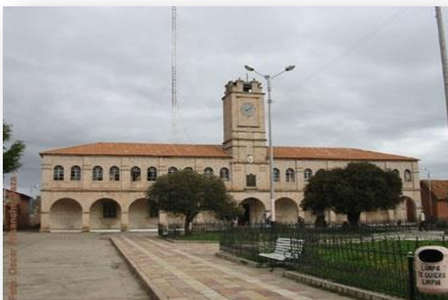
Figura N° 33 Palacio Municipal Lampa
