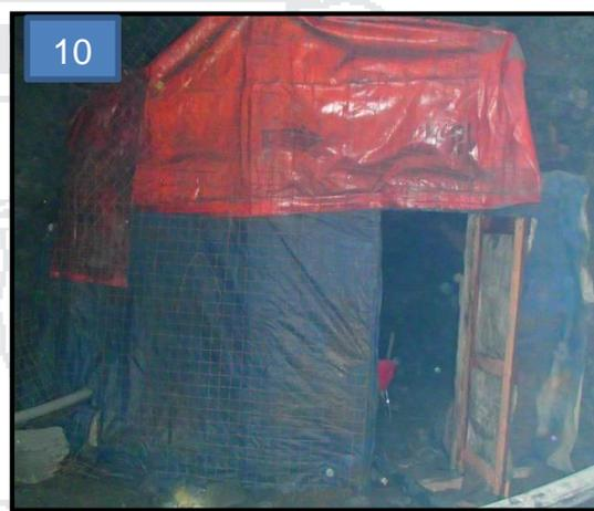
**Fotografía 09 y 10:** Labor hermético para direccionar el flujo y puerta de ventilación como regulador.
