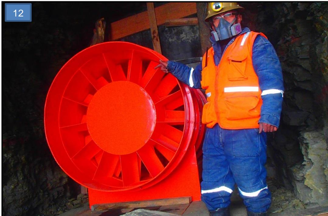
**Fotografía 12:** Ventilador instalado de 100 mil cfm como extractor subsistema III en el nivel 4949, crucero 512 Oeste vista hacia superficie.
