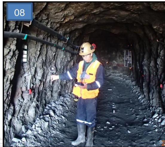
**Fotografía 07 y 08:** Medición de velocidad de aire con termo anemómetro en forma S.
