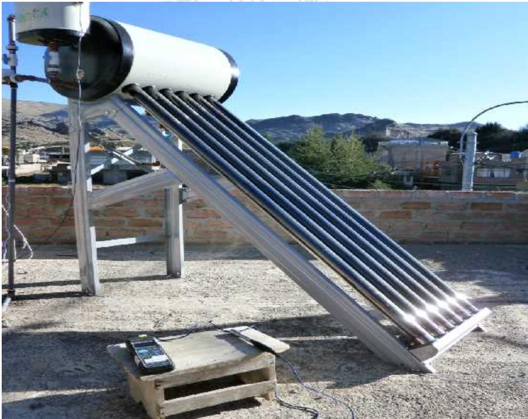
**Figura 14. Terma solar de tubos de vacío marca DAVSOL**
