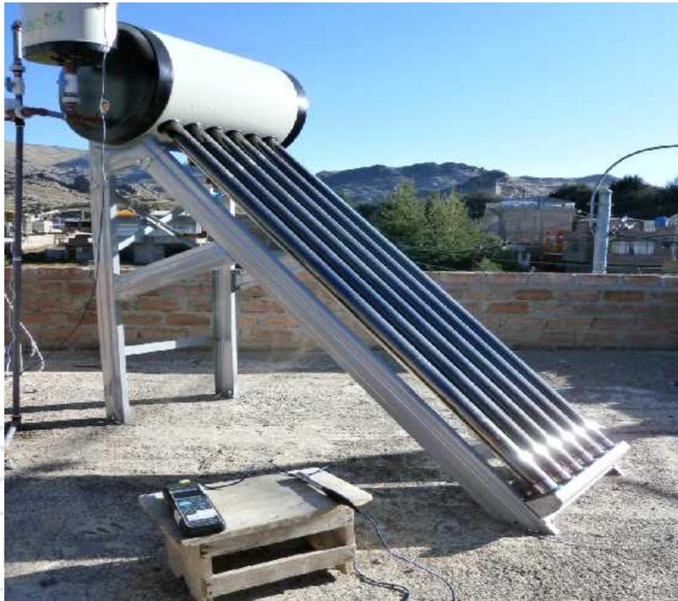
**Figura 5. Terma solar con tubos de vacío**
