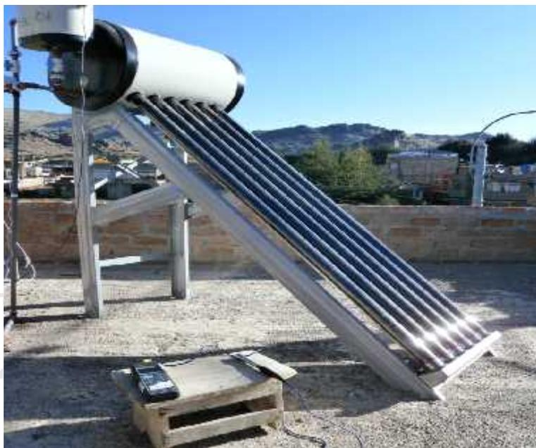
**Figura 1. Therma solar con tubos de vacío**
