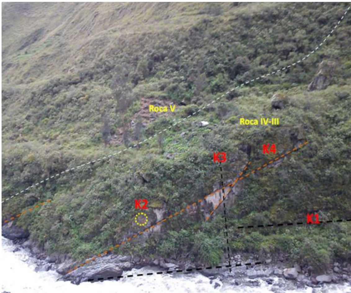
Fotografía 8: Mapeo Geológico – Geomecánico de la estación R-5, muestra el basamento rocoso de clase V que involucra la geología del Túnel.
