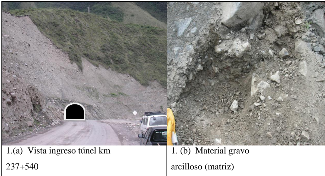
Fotografía 01: Mapeo Geológico-Geotécnico de la estación geotécnica S-1. Depósito Fluvio glaciar: Vista Panorámica del Portal de Entrada del Túnel Wayrasencca, mostrando el material gravo arcilloso como material matriz de la zona de portal Entrada. Fuente: Fotografía Propia
