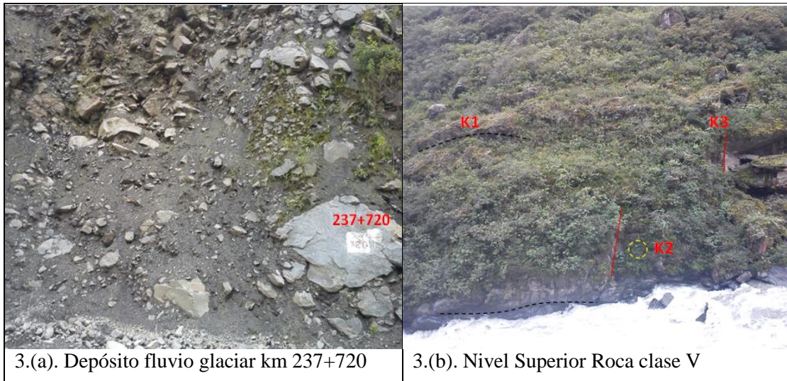
Fotografía 3: Mapeo Geológico – Geomecánico de la estación geomecánica R-1, que muestra zonas de depósito fluvio glaciar y Roca clase V, según la clasificación RMR. Fuente: Fotografía Propia
