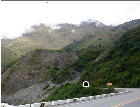
Fig. 9. (a). Portal salida túnel km 238+285
