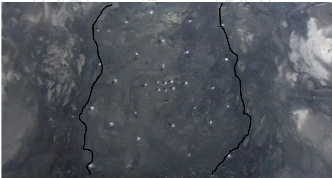
Figura 3: Imagen mostrando la deficiente voladura de la Galería 325. Fuente: Elaborado por el investigador.
