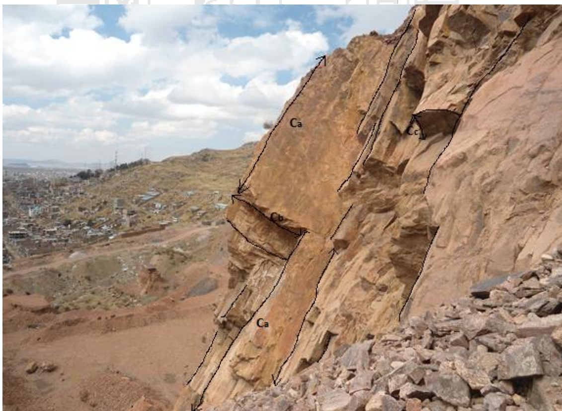
Foto 12 : Reconocimiento y medición de la continuidad o persistencia de las discontinuidades mayores y menores de las diferentes familias presentes en el talud.
