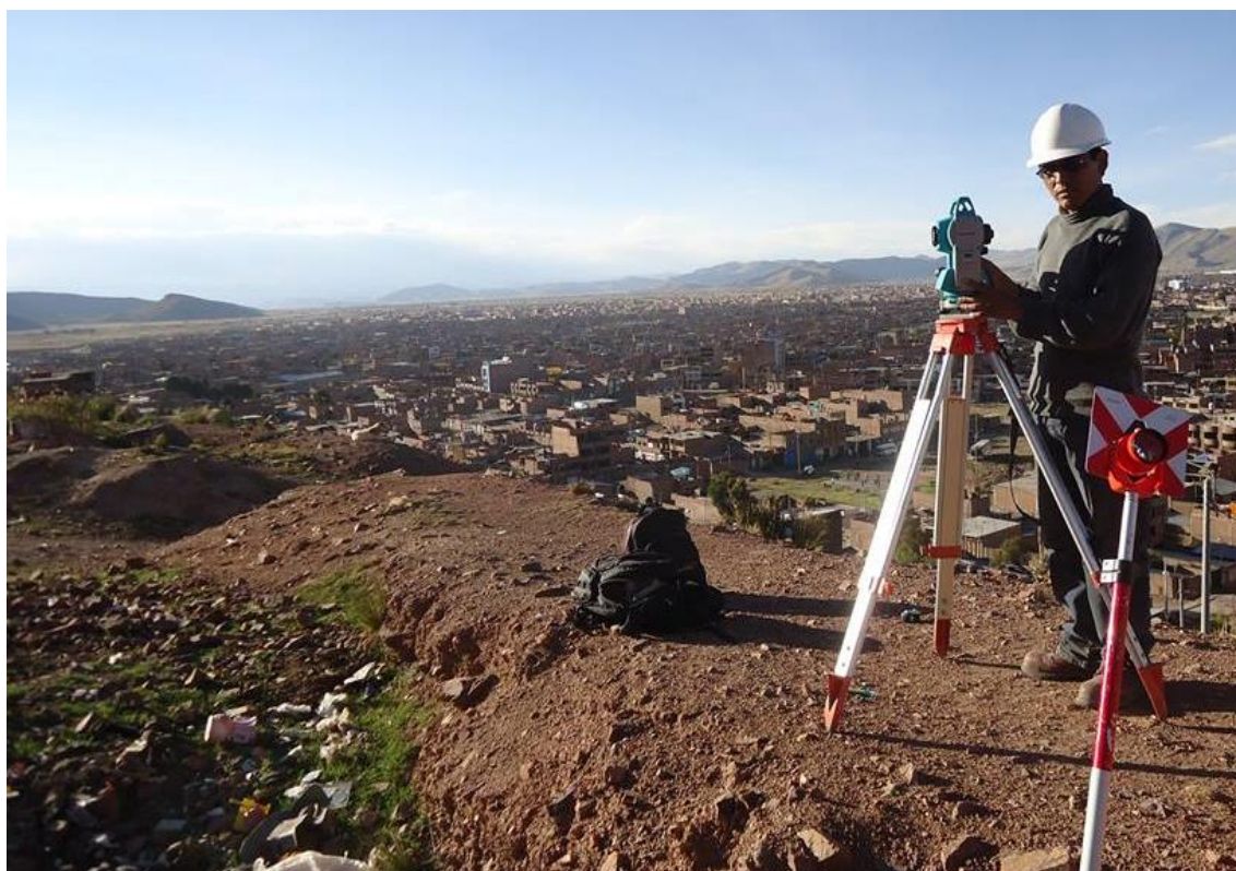
Foto 19 : Levantamiento topográfico con equipo de estación total.
