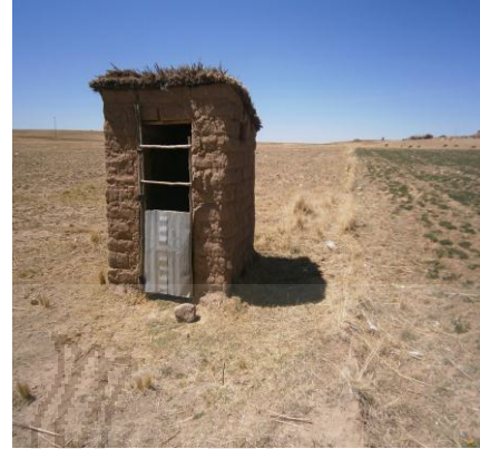
Letrina con puerta inadecuadamente
