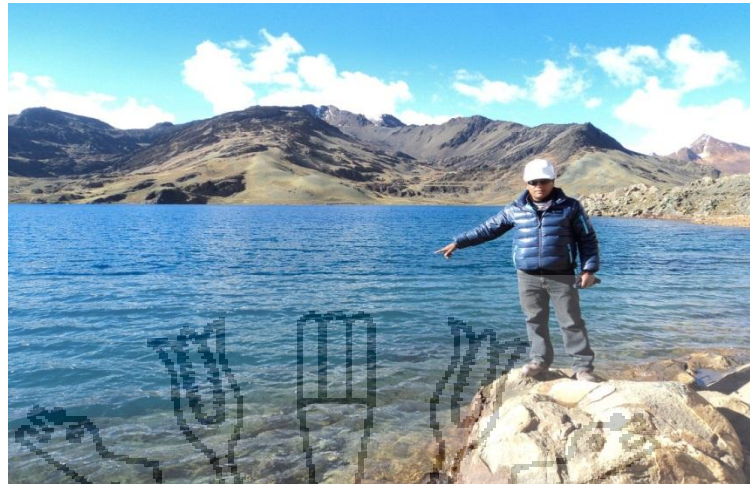
FOTO: 05 AGUAS ARRIBA DE LA PRESA
