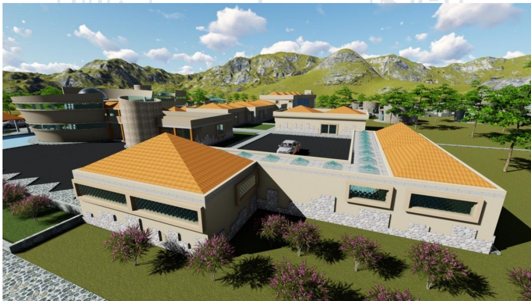
ILUSTRACIÓN 76 Vista del bloque de servicios complementarios
