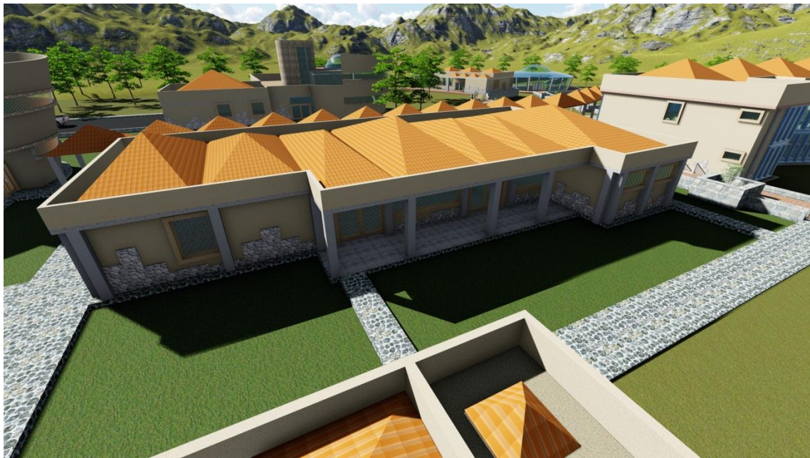
ILUSTRACIÓN 71 vista del bloque de restaurant
