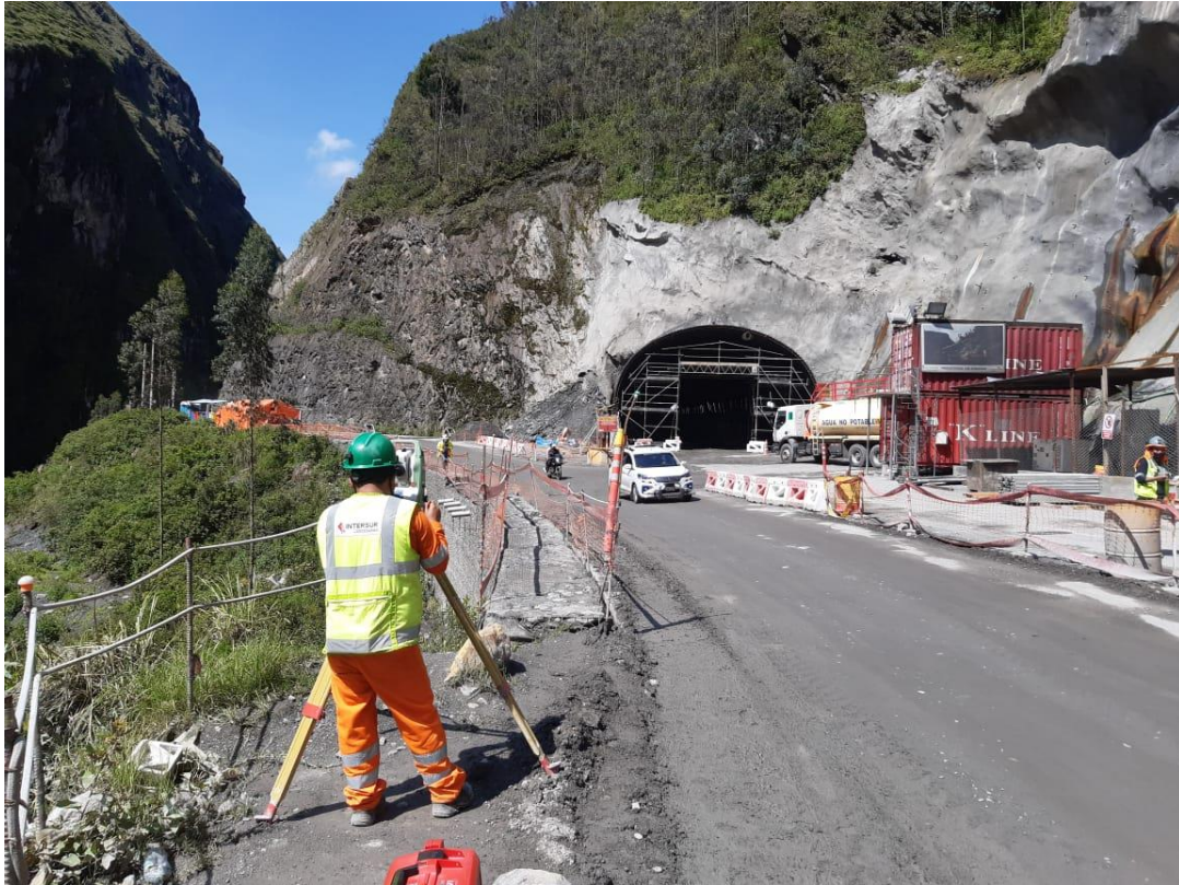
Fotografía 7. Control de la subsidencia en el túnel salida con estación total
