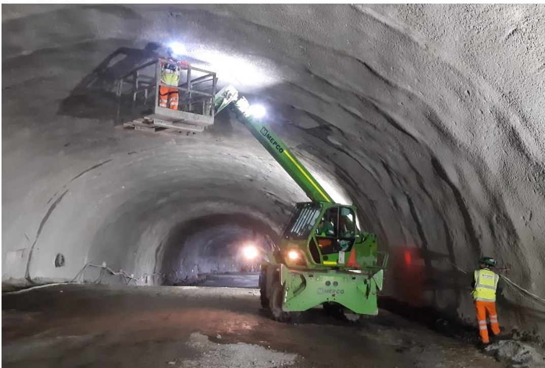
Fotografía 3. Colocación del extensómetro en el punto A
