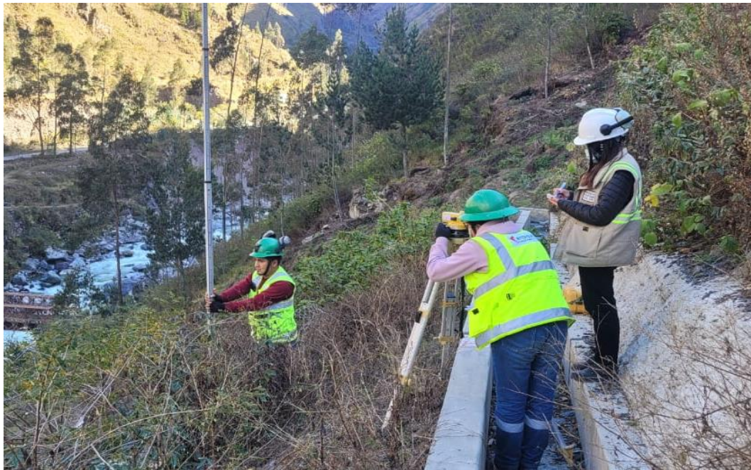
Fotografía 5. Control de la subsidencia en el túnel entrada con el nivel topográfico
