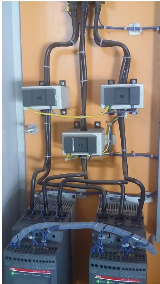
**Fotografía 9.** Transformador de control 380/220VAC
