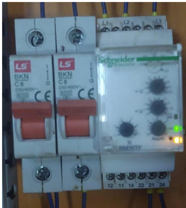
**Fotografía 11.** Interruptor general- conexionado deficiente
