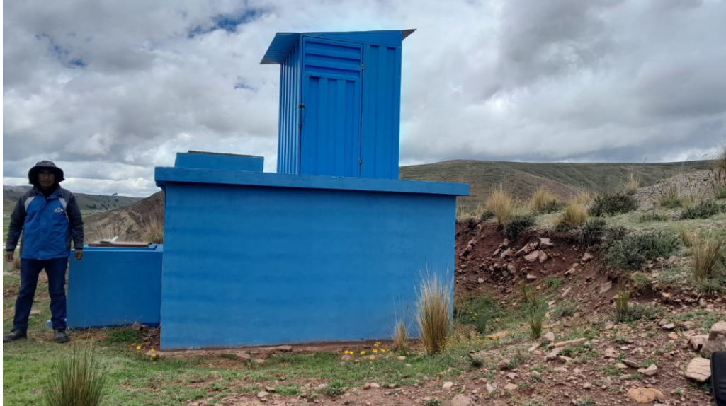
En la Foto se aprecia Reservorio de 4 m 3 de capacidad y Caceta de cloración
