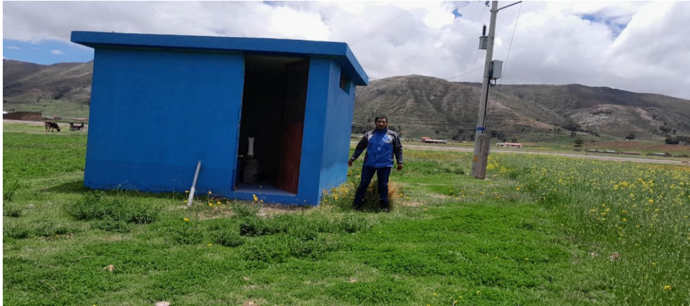
En la Foto se aprecia la caceta de bombeo
