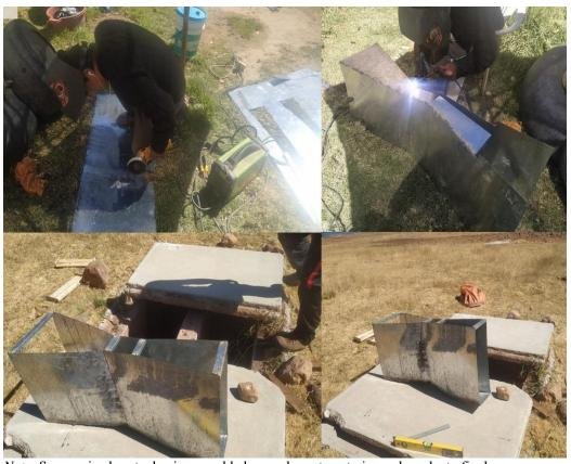
Nota. Se aprecia el corte de piezas, soldadura en la parte exterior y el producto final.
