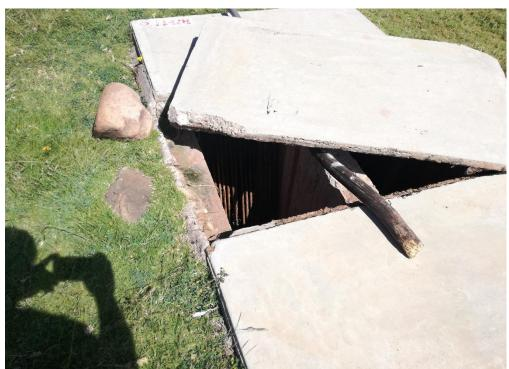
Nota: Se visualiza que la cámara de rejas tiene tapa de concreto.
