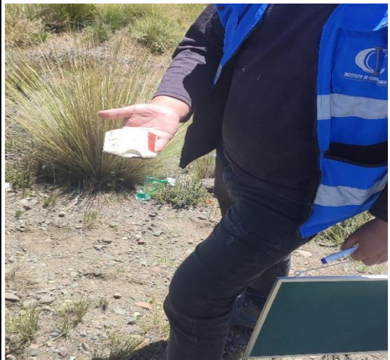
Punto negro 08: Desprendimiento de tachas
