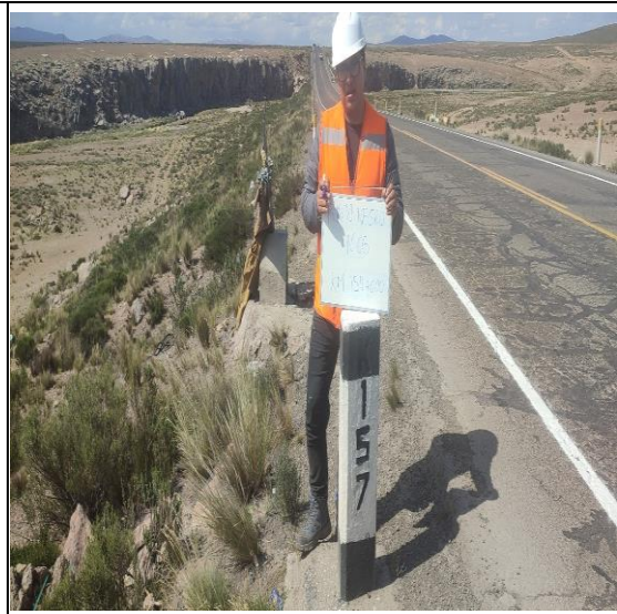
Punto negro 05: Presencia de nichos
