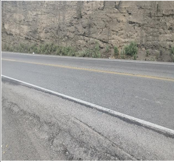
Punto negro 02: Pavimento en un buen estado
