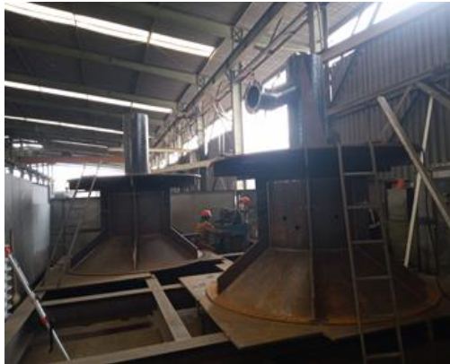
a) ARMADO Y SOLDEO MOD3 C2-2883@2884
