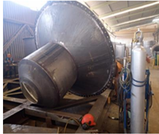
b. HABILITADO DE BITAULICA PARA CELDAS
