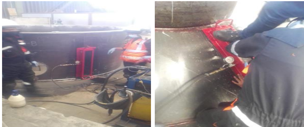
a. ENSAYO DE VACUM TEST C2-2871@2876
