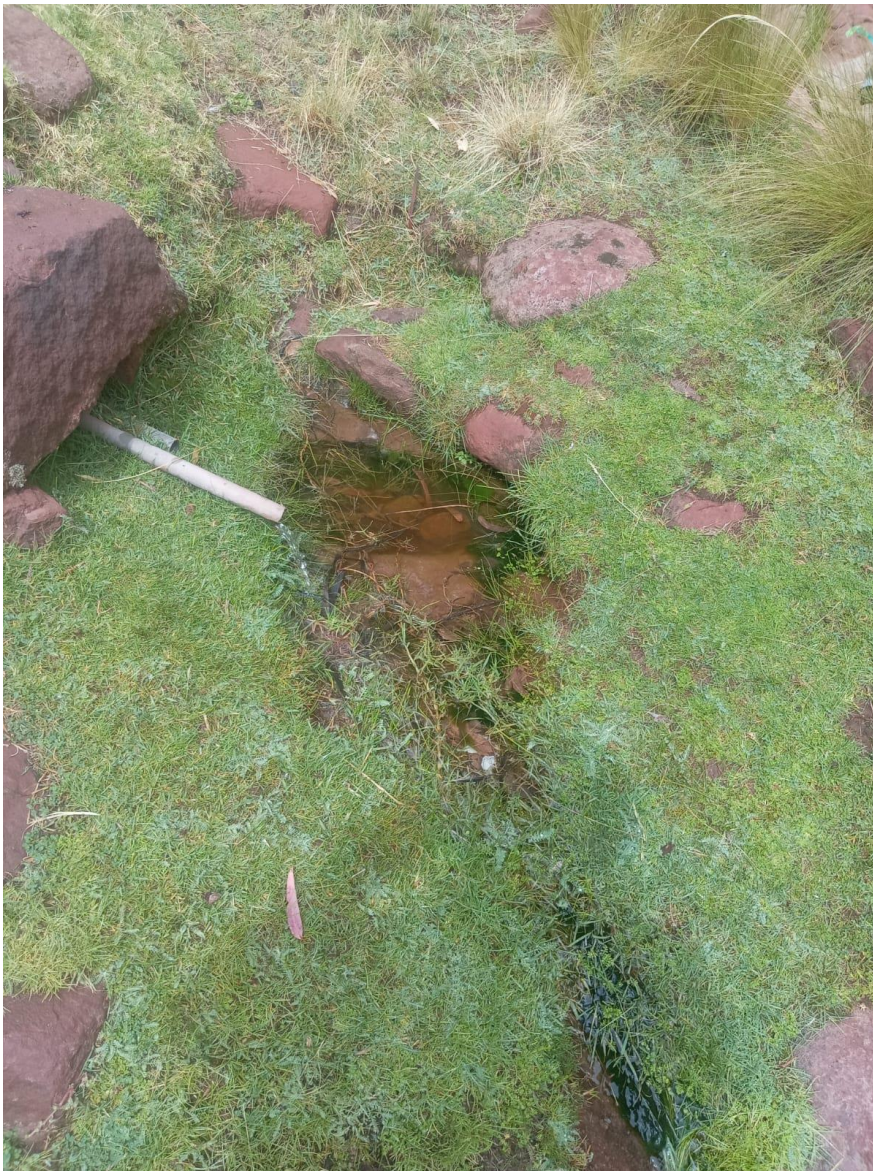
Nota: Tubería de desfogue del reservorio Challapampa
