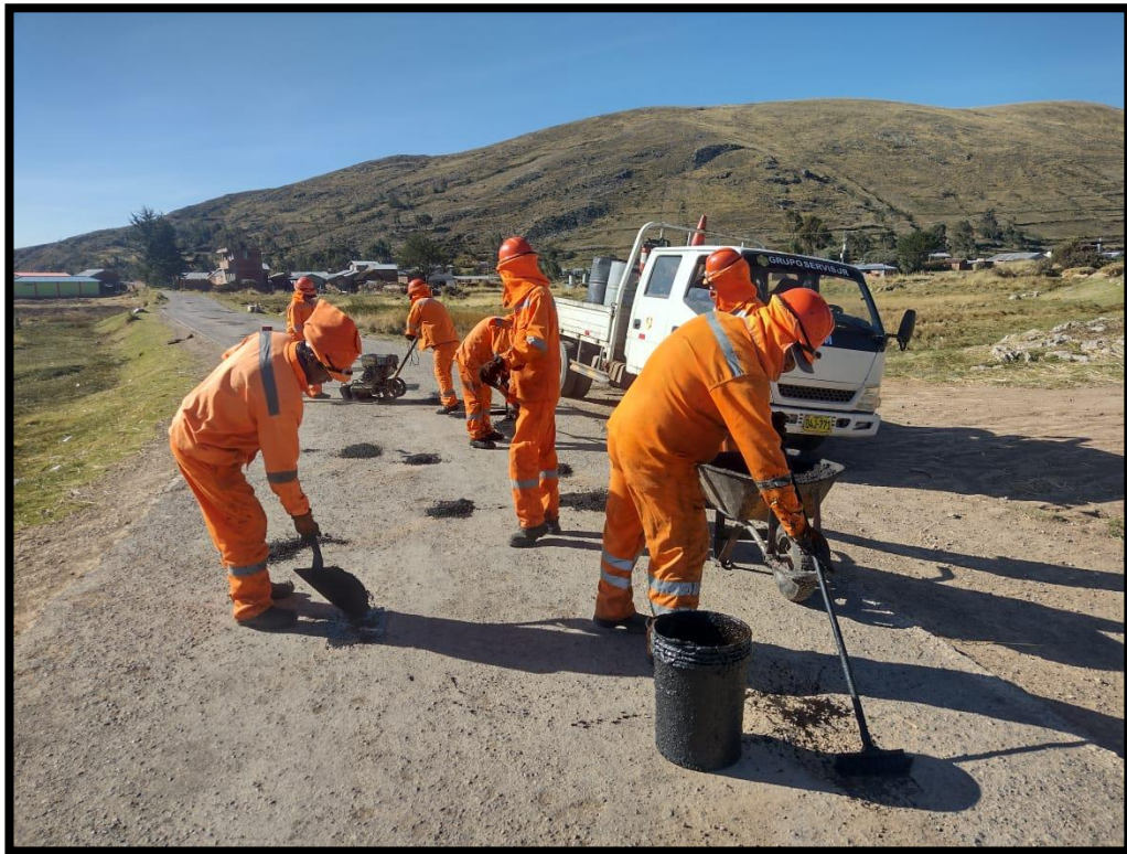
Trabajos de mantenimiento rutinario
