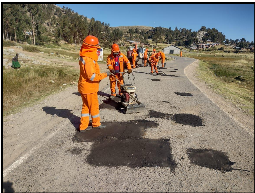
Trabajos de mantenimiento rutinario
