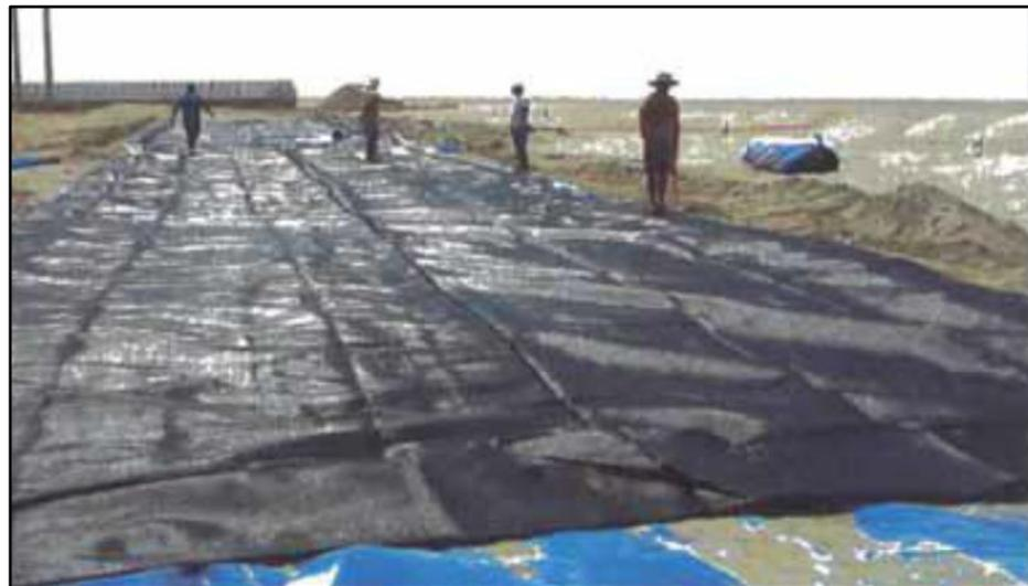
Nota: Se muestra la colocación del manto antisocavante ante socavación de riberas, tomado de Aplicación del geotubo para reducir la socavación hídrica en el río Rímac, tramo Puente Av. Morales Duarez - Puente Rímac, por Ruiz Córdova, J. W., 2019.
