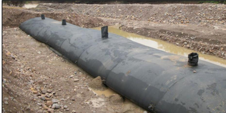
Nota: Tubo de geotextil instalado, tomado de Geotextile Tubes for Hydraulic Structures, por Geomatrix, 2021.
