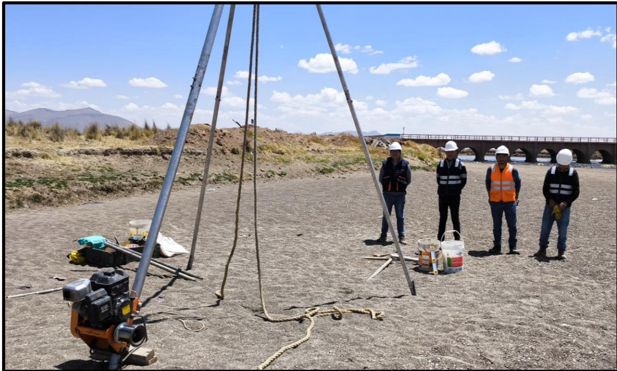
Figura 8 - 12 Sondeo de Penetración Estándar (SPT)
