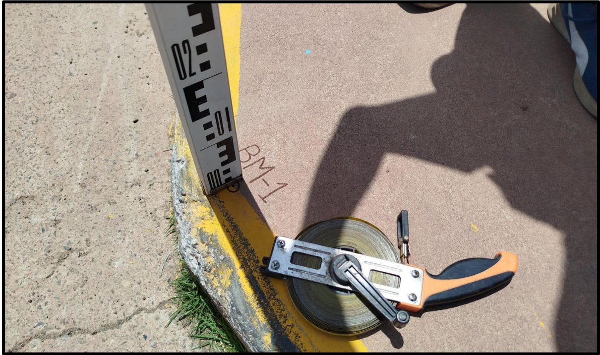
Figura 8 - 11 Colocación de BMs para el estudio topográfico
