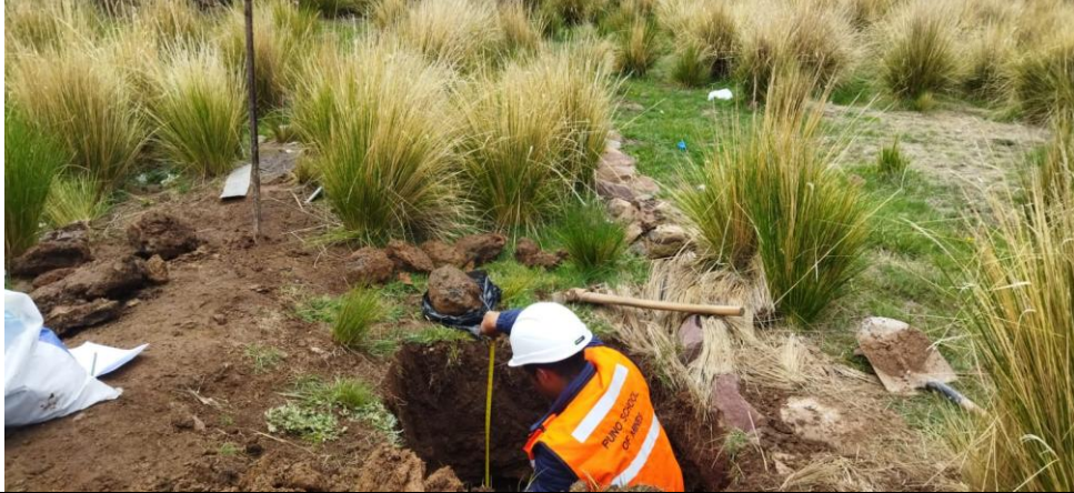
Descripción: Medición de la profundidad de la calicata.
