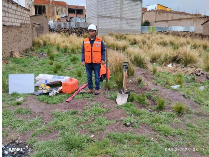
Descripción: Reconocimiento de terreno y preparación de equipos y materiales.
