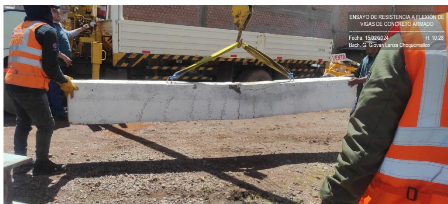
Fotografía 16: Transporte de vigas de concreto armado después del ensayo de resistencia a flexión.
