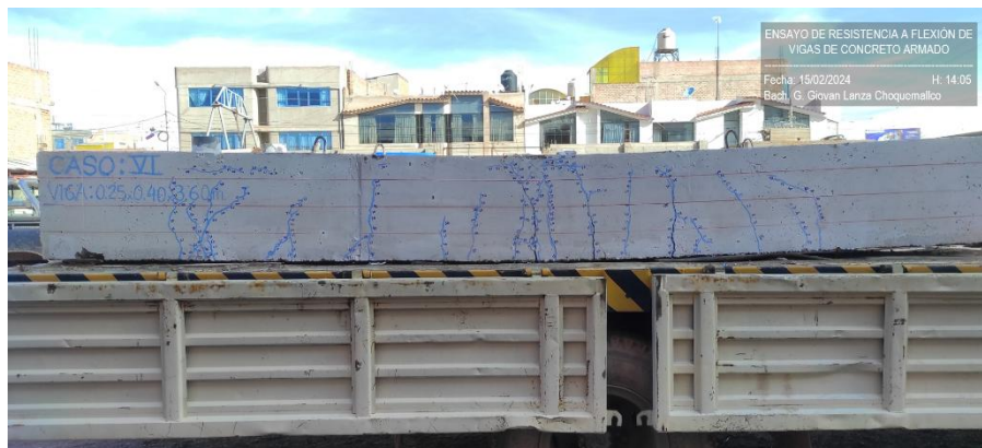
Fotografía 19: Ensayo de resistencia a flexión y fisuras de vigas de concreto armado para el Caso VI.
