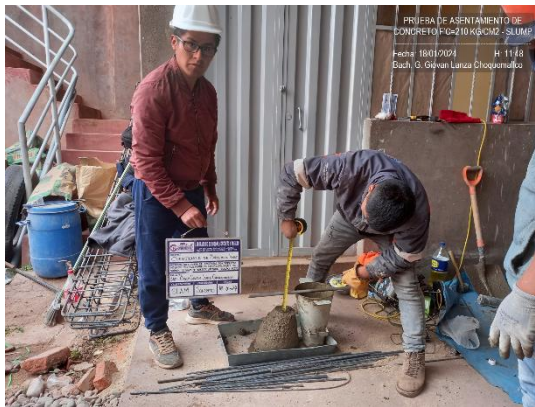
Fotografía 07: Ensayo de asentamiento (SLUMP) para la prueba de calidad y consistencia de concreto.
