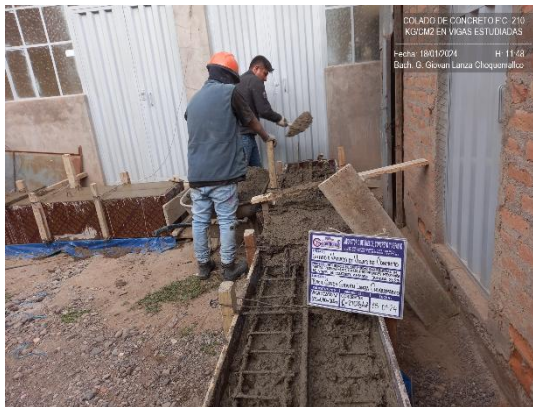
Fotografía 10: Colado o vaciado de concreto en las vigas para todos los casos estudiados.
