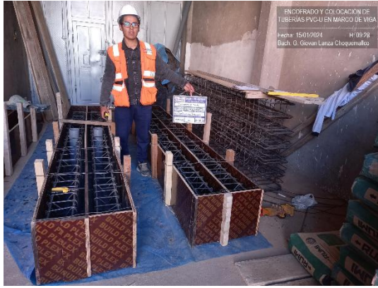
Fotografía 05: Encofrado y armado de refuerzo longitudinal y transversal de aceros en las vigas.
