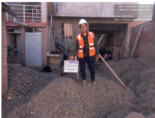
Fotografía 04: Habilitación de los agregados fino y grueso tanta total de 10m 3 de la cantera Isla.
