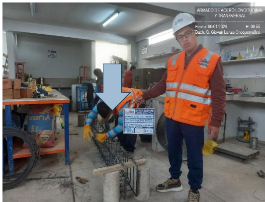
Fotografía 03: Construcción y armado de refuerzo longitudinal y transversal para el cuerpo de vigas.
