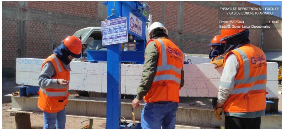
Fotografía 17: Ensayo de resistencia a flexión y fisuras de vigas de concreto armado para el Caso VI.
