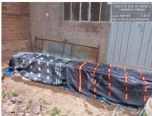
Fotografía 12: Curado de las vigas fabricadas con mantas húmedas o sumergidas con agua.
