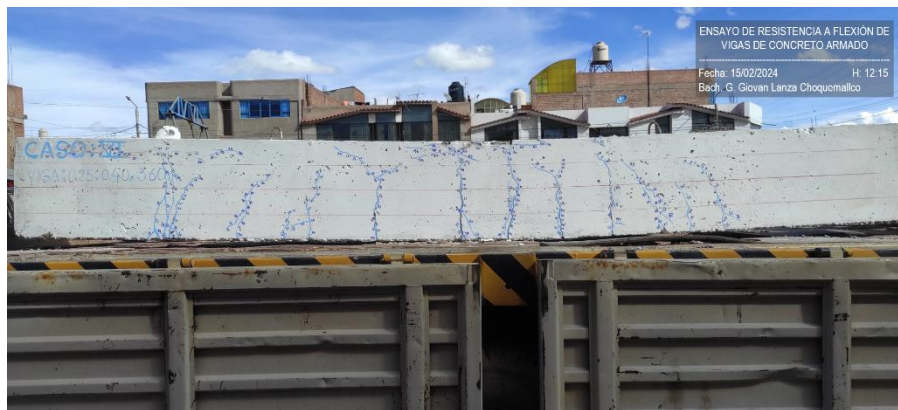
Fotografía 15: Ensayo de resistencia a flexión y fisuras de vigas de concreto armado para el Caso VI.
