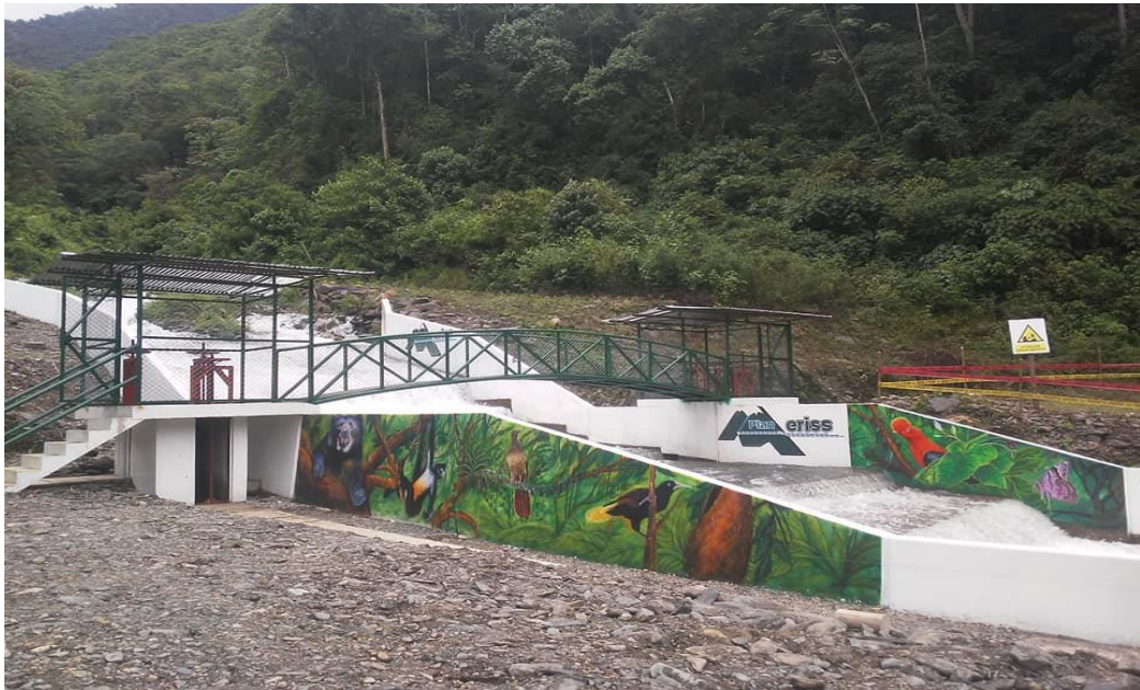
Bocatoma del sistema 03 de Santa Elena- Nueva Granada
