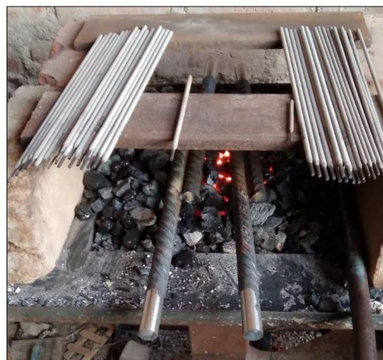
Nota: Pre calentamiento de las varillas de acero corrugado y electrodos, previo a la aplicación de soldadura SMAW E7018.
