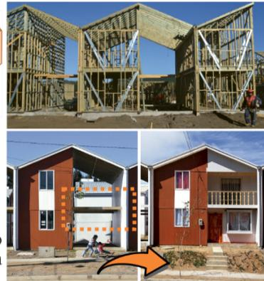
El edificio Villa verde, utiliza muy eficazmente el uso de la madera. Asimismo, esta estructura es ejecutada por paneles estructurales, con el fin de que en una futura ampliación se utilice el mismo sistema de paneles. Se emplea a su vez, un montaje de bajada de lluvias que es colocado entre cada vivienda adosada a otra.
