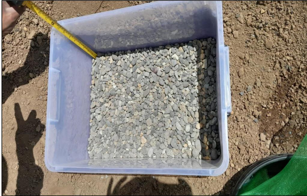
*Foto 3.* Llenado de Lisímetro de drenaje con grava fina de  $\varnothing \frac{1}{2}$ " encima de la grava gruesa por un espesor de 4 cm.
