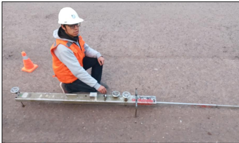
Figura 8.21: Medición de deflexiones con la viga Benkelman
