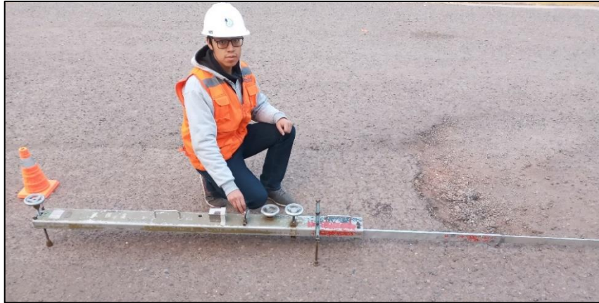
Figura 8. 20: Medición de deflexiones con la viga Benkelman
