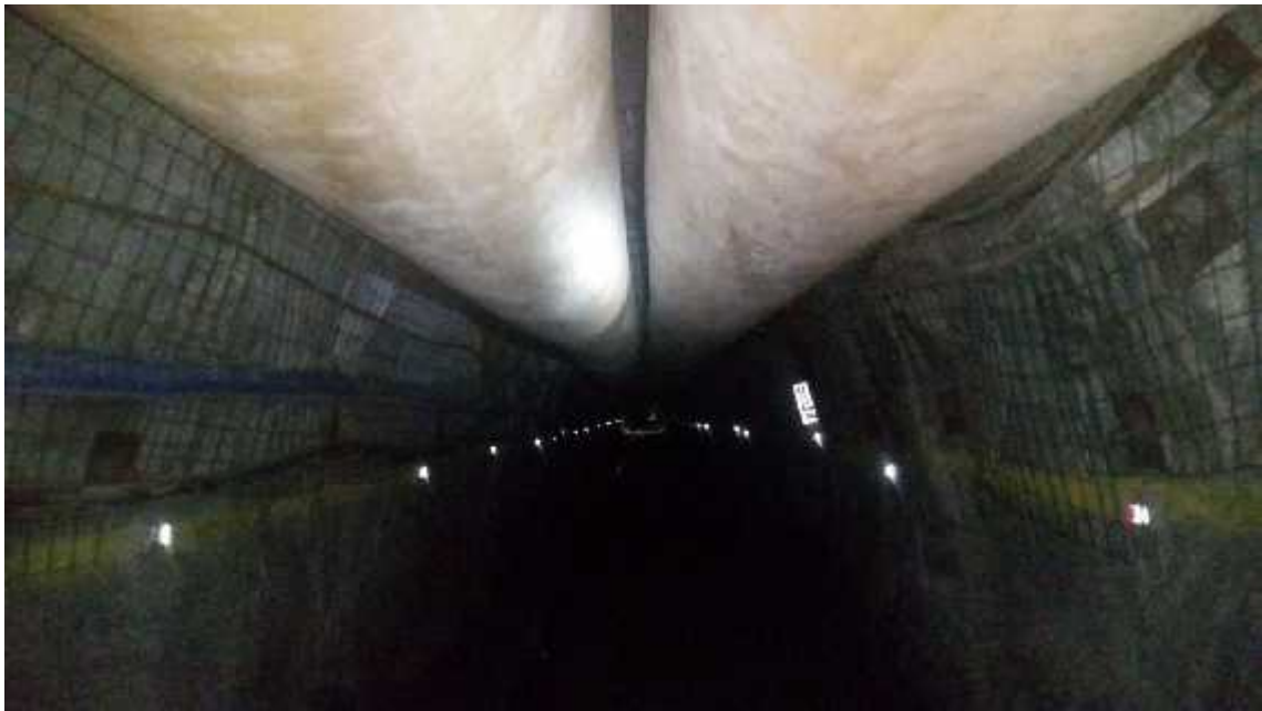
Figura 03.04: Instalación de mangas de ventilación
