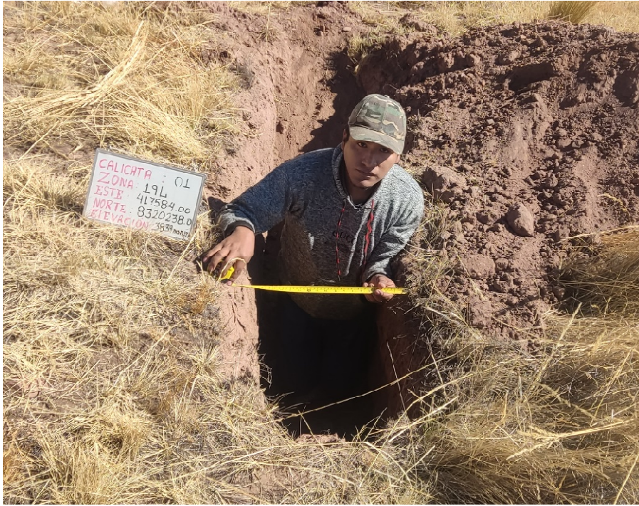
Fotografía 1. Apertura y medición de calicatas
