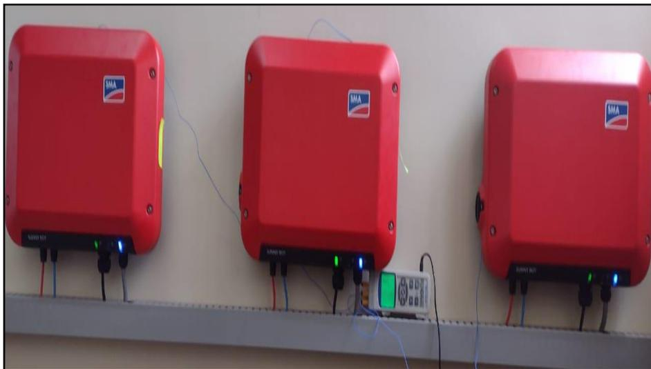
Nota: La figura muestra el medidor de temperatura para verificar la temperatura de lo inversores.
