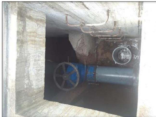
Nota: Sirve para cambiar las dimensiones de agua de paso.
