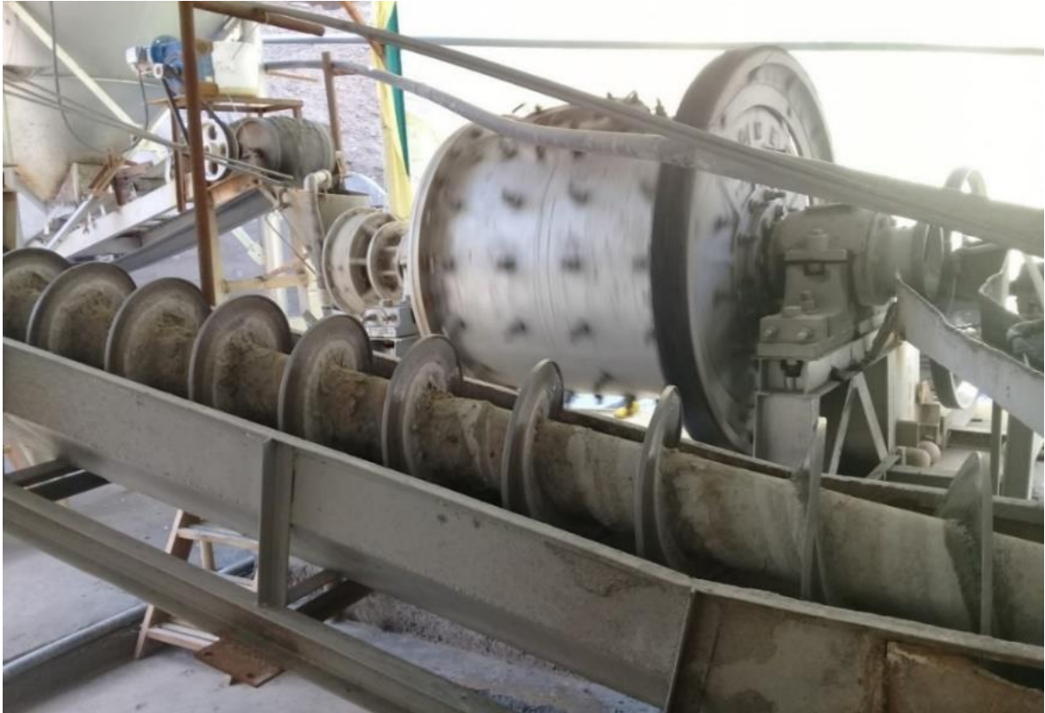
Clasificador Helicoidal 16 * 15 del Circuito de Molienda de la Planta San Carlos.
