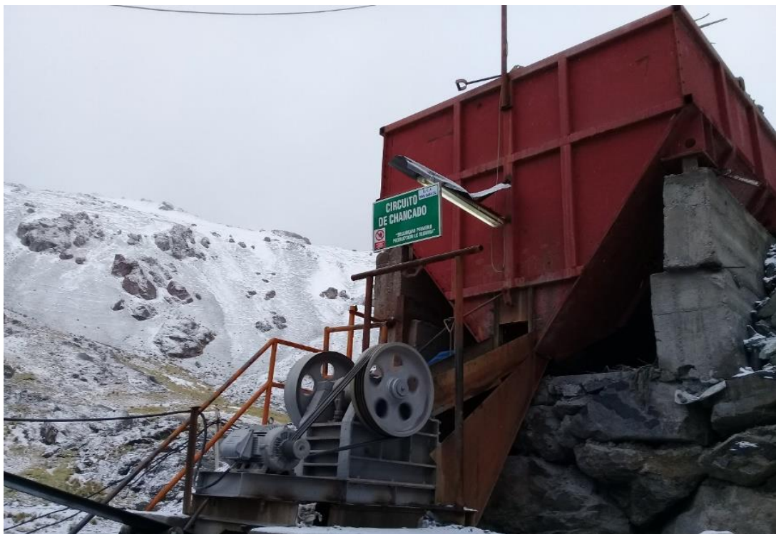
Tolva de gruesos del circuito de Chancado de la Planta San Carlos.
